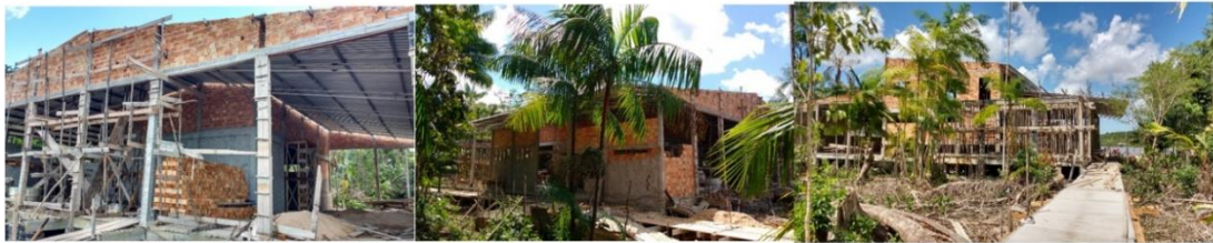
Lateral, Fachada e Sala de Bateção em novembro de 2018
